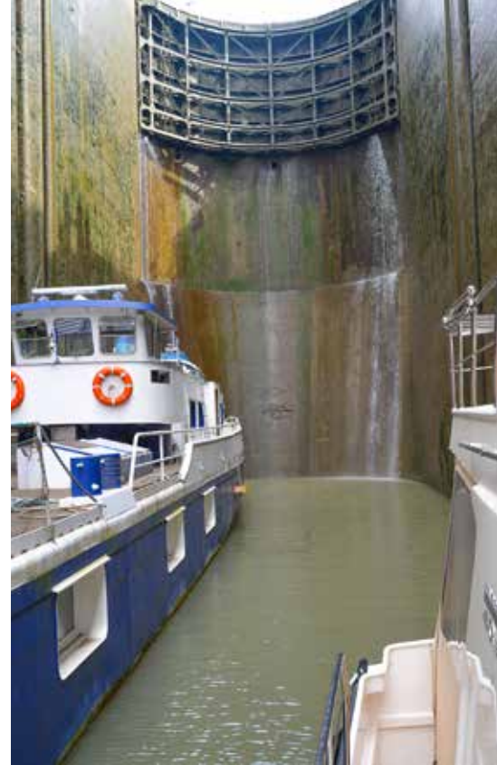
Die Schleuse von Bollène überwindet 22 m Höhenunterschied.
