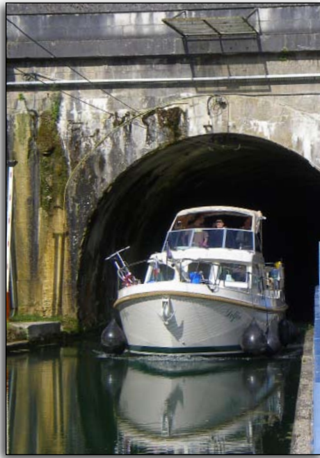
« ...le tunnel de Demange à Mauvages... »
