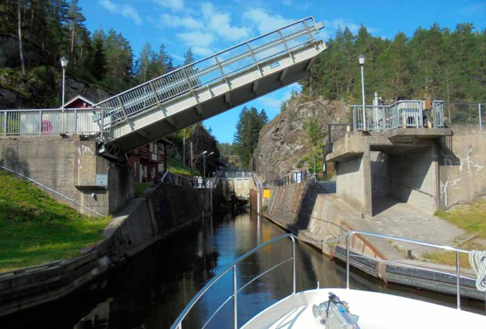
The Løveid locks on the Telemark canal
