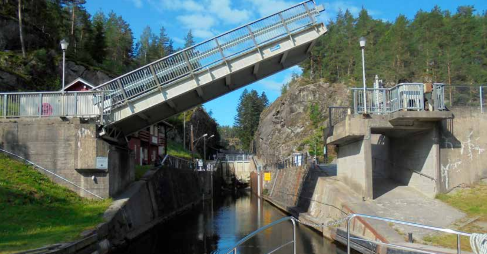
Die Løveid-Schleusen im Telemarkkanal
